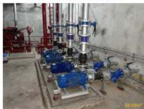
ปั้มน้ำ/ปั้มเสริมแรงดันอาคาร B
