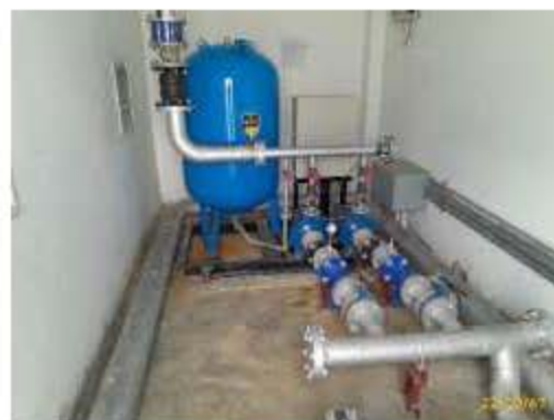
ปั้มน้ำ/ปั้มเสริมแรงดันอาคาร B
